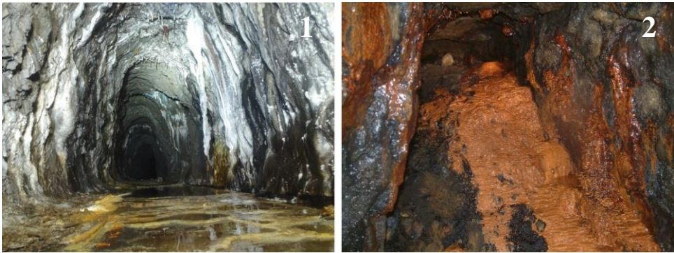
Abb. 7: Ausfällungen von Carbonaten (1: Pflingstwiese, Bad Ems) und Eisenhydroxiden (2: Alvenslebenstollen, Westerwald).
