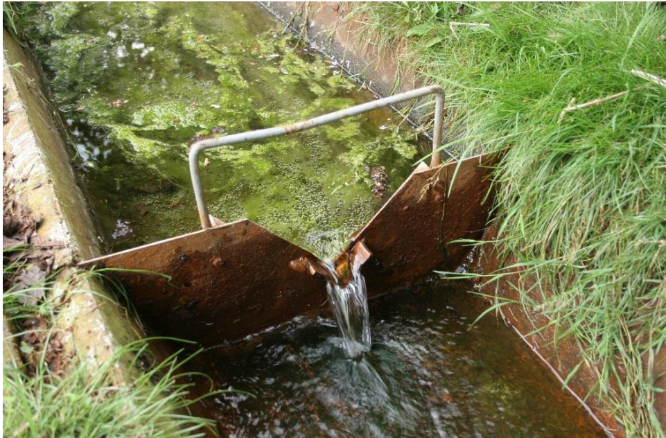
Abb. 12: Verkrautetes Messgerinne und falsch konstruiertes Messwehr (Harz).
