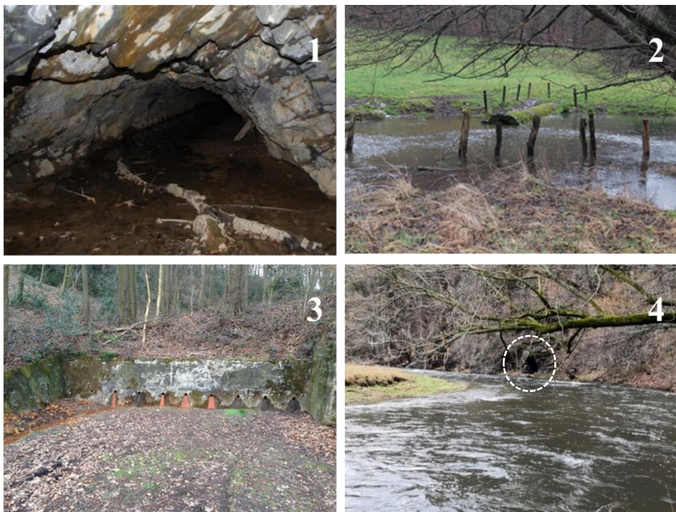
Abb. 4: Schwer zugängliche Stollenmundlöcher in der Freiburger Mulde (1 und 4); Zuflüsse unterhalb des Wasserspiegels (2: Kreßsieper Erbstollen, Sprockhövel) und über unterirdisch verlegte Rohre, an denen aufgrund der baulichen Gegebenheiten keine Probenahme möglich ist (3: Sonnenscheiner Stollen, Bochum).
